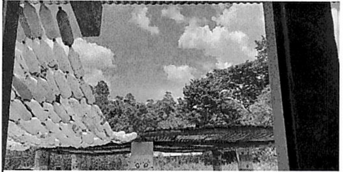
Foto 2: Sustición de Estructura Metalica y Lámina troquelada Aluzinc calibre 26
