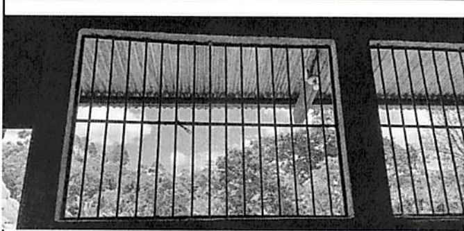
Foto 1: Sustitución de de Ventana de PVC y Mantenimiento a Balcones de metal (pintura)
